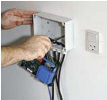
**1** Den Steuerkasten so anbringen, dass alle Kabel/Leitungen zugänglich sind. Ein Kabel verläuft zum Motor der Förderschnecke, eines zum Brenner. Außerdem ist einer Sensorleitung vorzusehen, die Anschluss über die aktuelle Temperatur gibt.
